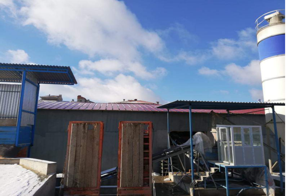
Fen İşleri Müdürlüęü Taş İmalat Tesisi Çatı Yapımı
