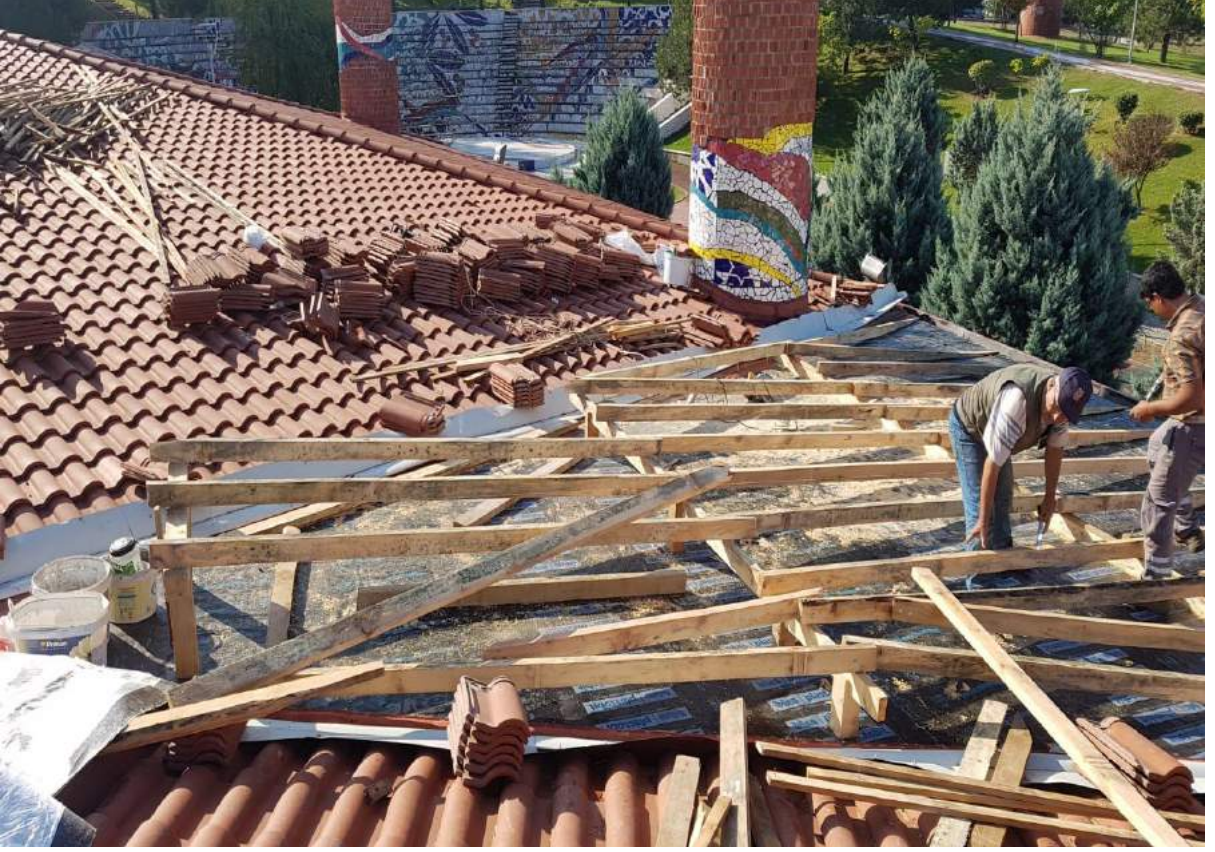
Seramik Park çatısının bir kısmının yükseltilmesi
