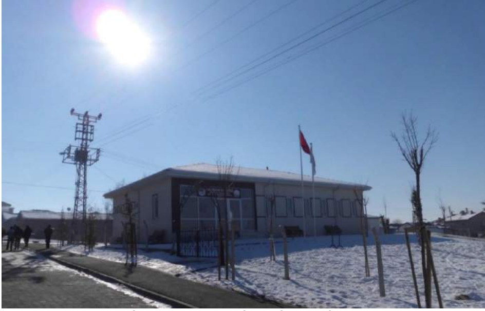
SEVİNÇ MAHALLESİ TAZİYE EVİ
